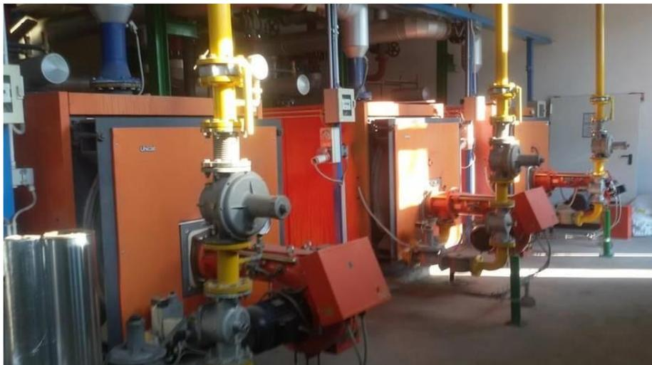
Ad integrazione nei momenti di maggior richiesta da parte della rete l'impianto integra la produzione di energia termica mediante delle caldaie a gas
