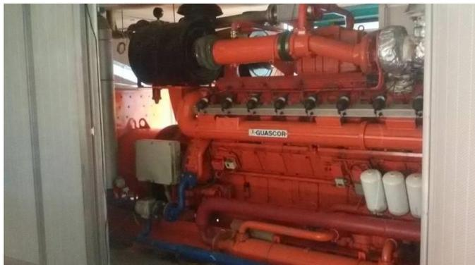
Negli impianti di cogenerazione (COGE) vengono prodotti **contemporaneamente sia energia elettrica che calore** secondo il principio dell'abbinamento forza-calore.
